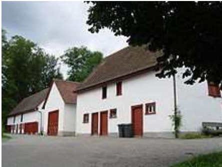
Ökonomiegebäude beim Jagdschloss
